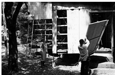
舞台改修作業
