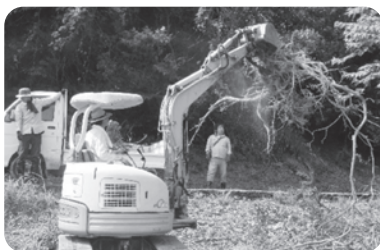
抜根作業、大きな根っこが出てきました!!
