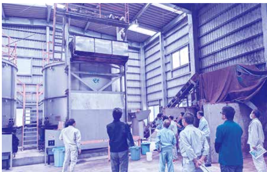
（対馬市生ごみ等堆肥化施設）
