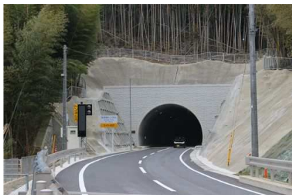
平成 27 年に完成した対馬最長の 佐須坂トンネル(1,867m)
