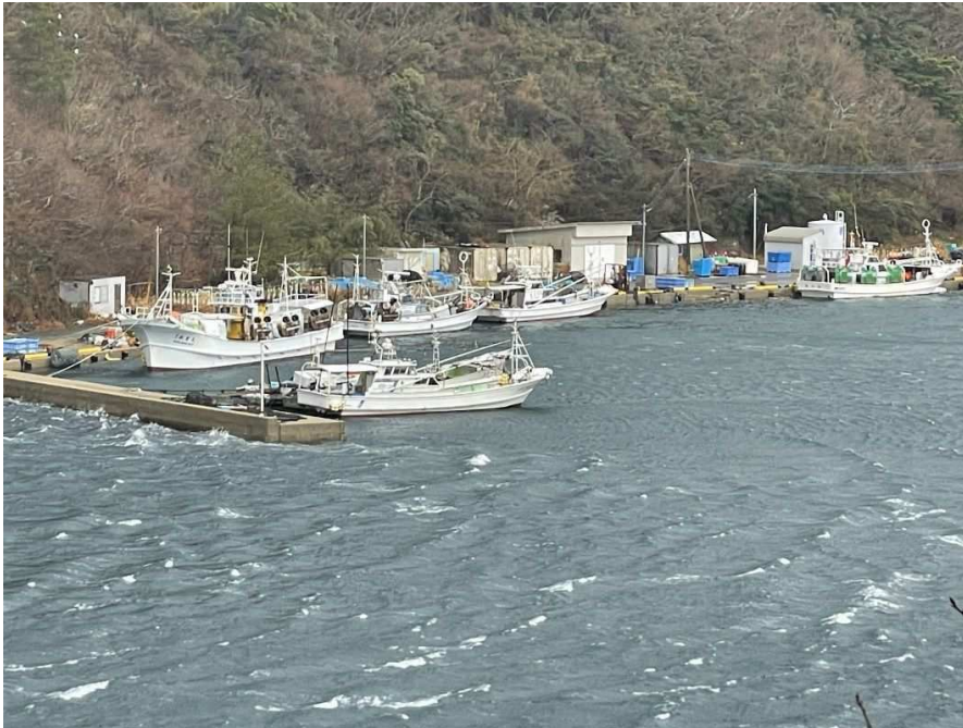
① 港内荒天時状況
