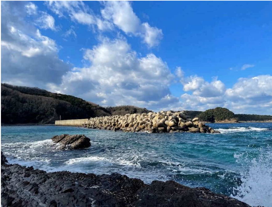
① 港内荒天時状況
