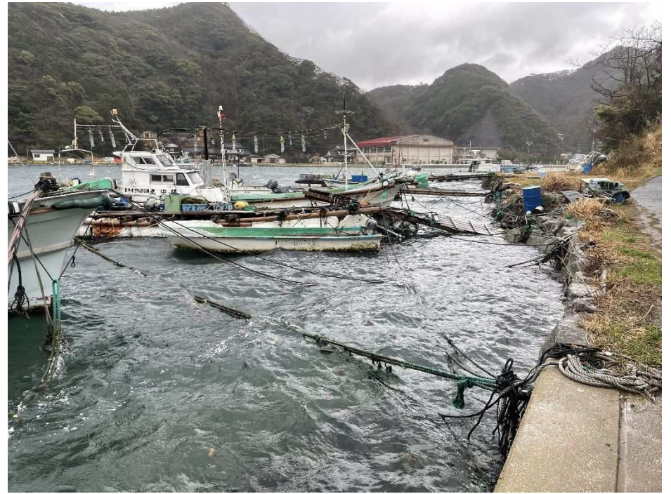
④ 港内荒天時状況
