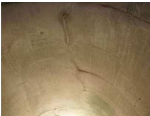
ひび割れ状況 (犬ヶ浦トンネル)
