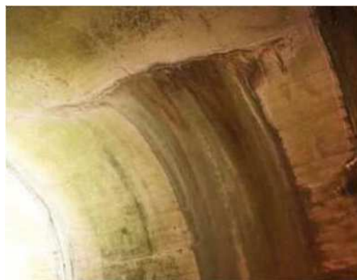
漏水状況 (犬ヶ浦トンネル)
