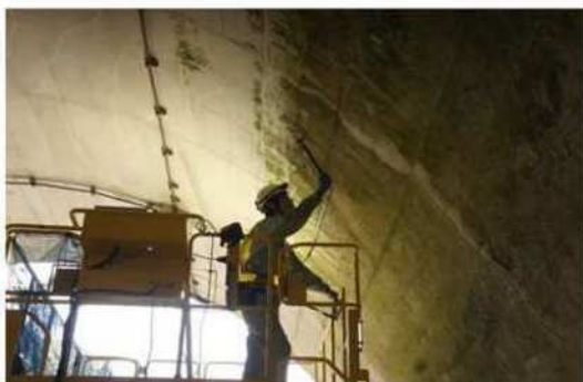
近接目視・打音検査状況
