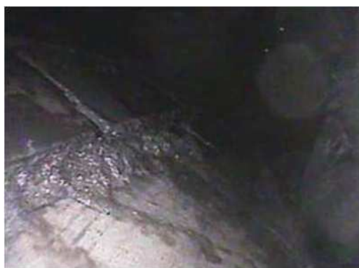
覆工背面の空洞状況 (佐奈豊トンネル)
