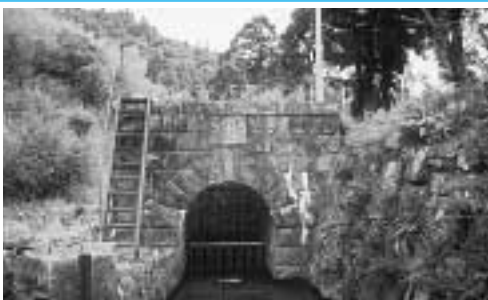
20世紀初頭の明治期に築かれた石造の水門
