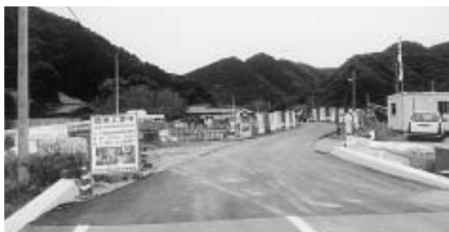
吉田曾線道路改良工事
