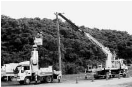
現代生活に不可欠な電気。折れた電柱の仮復旧訓練を行う九州電力(株)のみなさん
