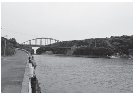
美津島町鴨居瀬・赤島大橋
