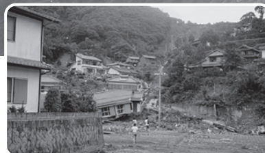
土石流による被害状況（長崎大水害）
