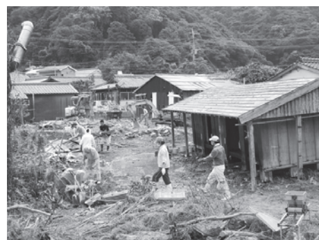
平成27年9月に発生した瀬地区豪雨災害の復旧作業
