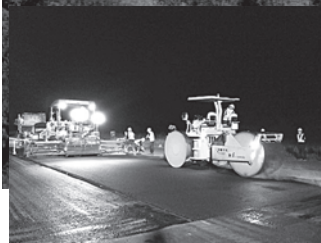
夜間工事の状況
