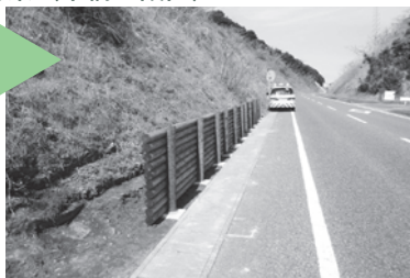
猪被害による落石対策（木柵の設置）！
