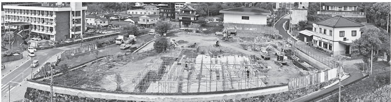
平成30年4月26日時点（鉄筋組み上げ中）
