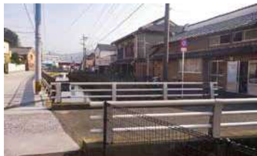
十王橋のたもとに開放された水栓があった
