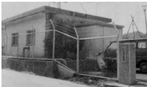
昭和50年頃の仁位浄水場
