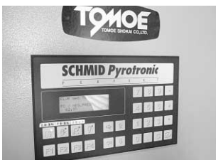
自動制御装置で常に最適な燃料と空気バランスで燃焼します。
