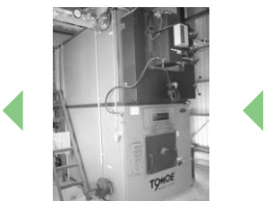
チップボイラーです。化石燃料を全く使わず、24時間無人運転されています。
