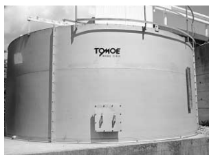
チップは直径6メートル高さ2.5メートルのサイロへ。
