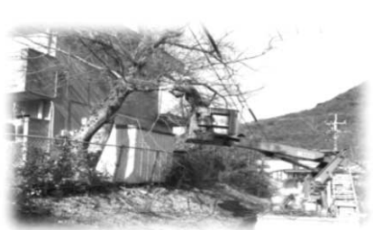
高木伐採 【峰町三根下地区】
