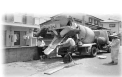
市道整備 【美津島町高浜地区】
