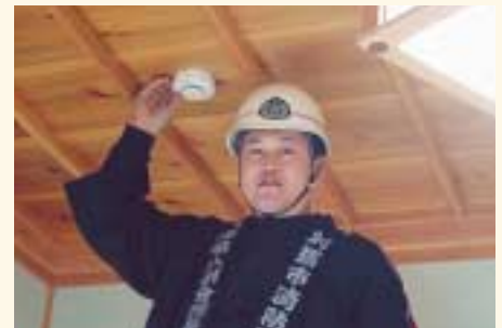
住宅用火災警報器の取り付け様子(安神地区)
