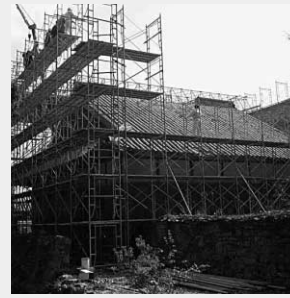
解体前の様子 全景
