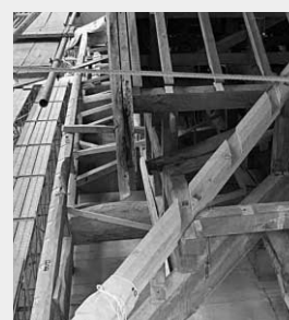
木材修理の様子
