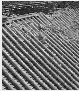
解体途中の様子 屋根
