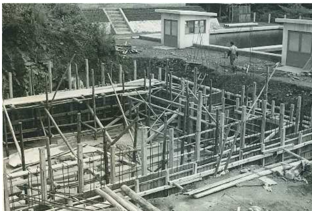
建設途中の緩速ろ過池（砥石淵浄水場）
