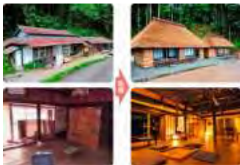
空き家の改修
