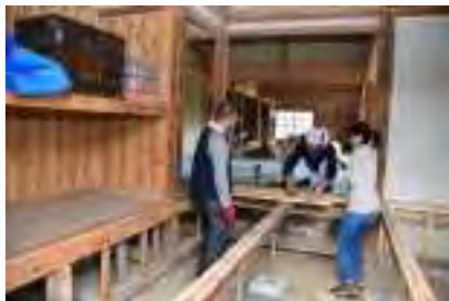
空き家の改修
