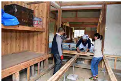
空き家の改修
