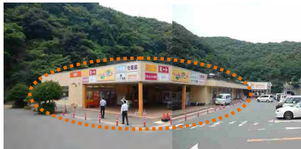
ハートランドの改修
