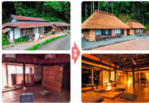
空き家の改修
