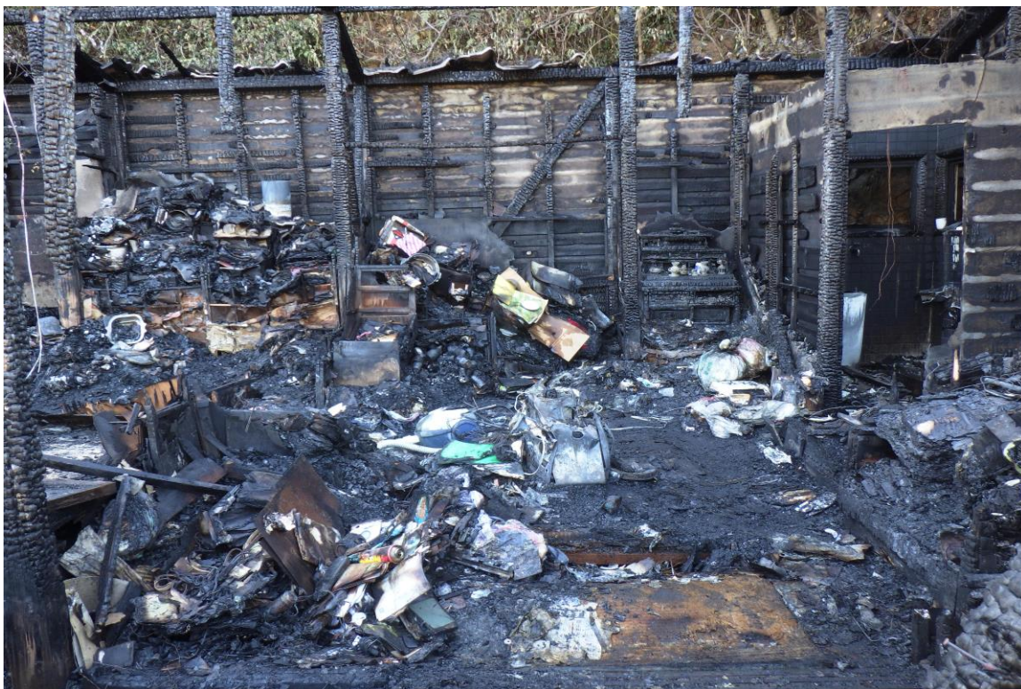
建物火災 現場写真
