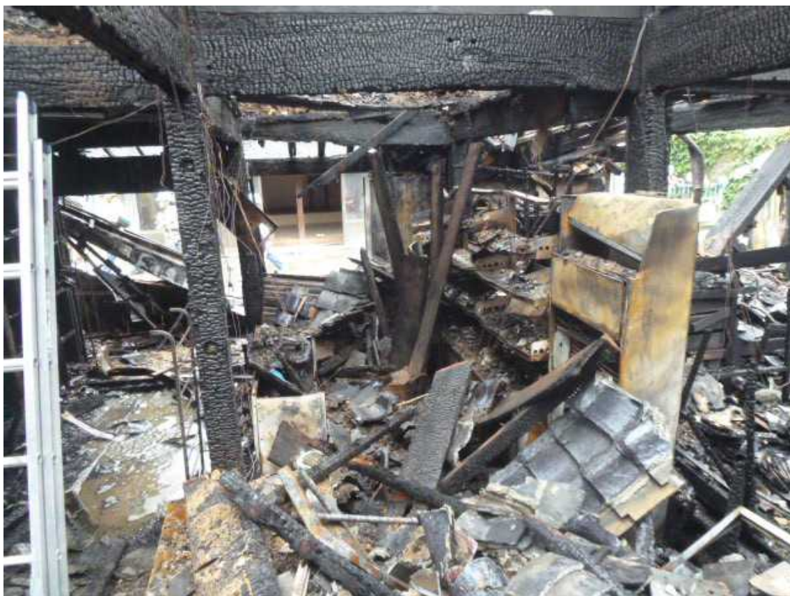
建物火災 現場写真
