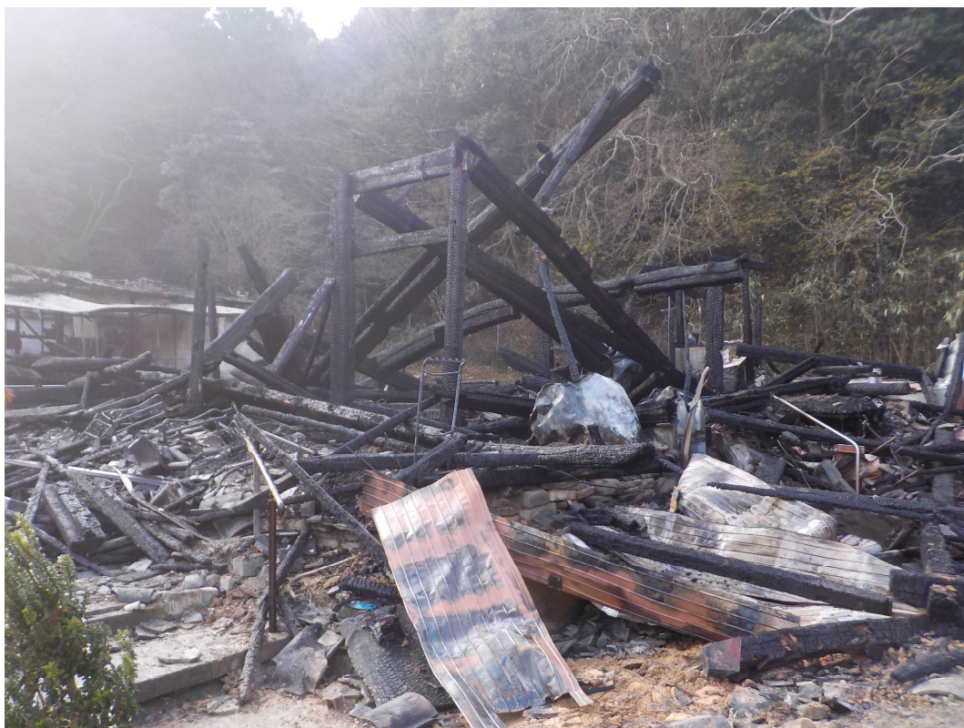
美津島町加志（建物火災）
