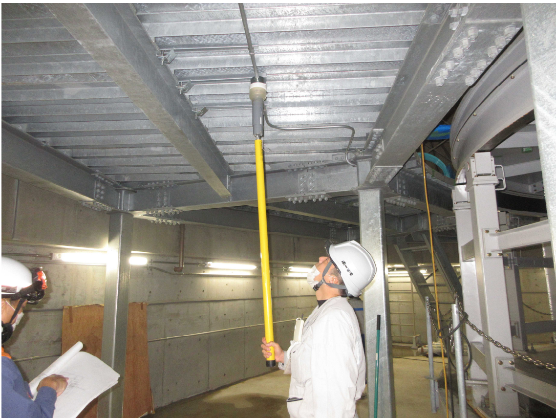
消防用設備設置検査中
