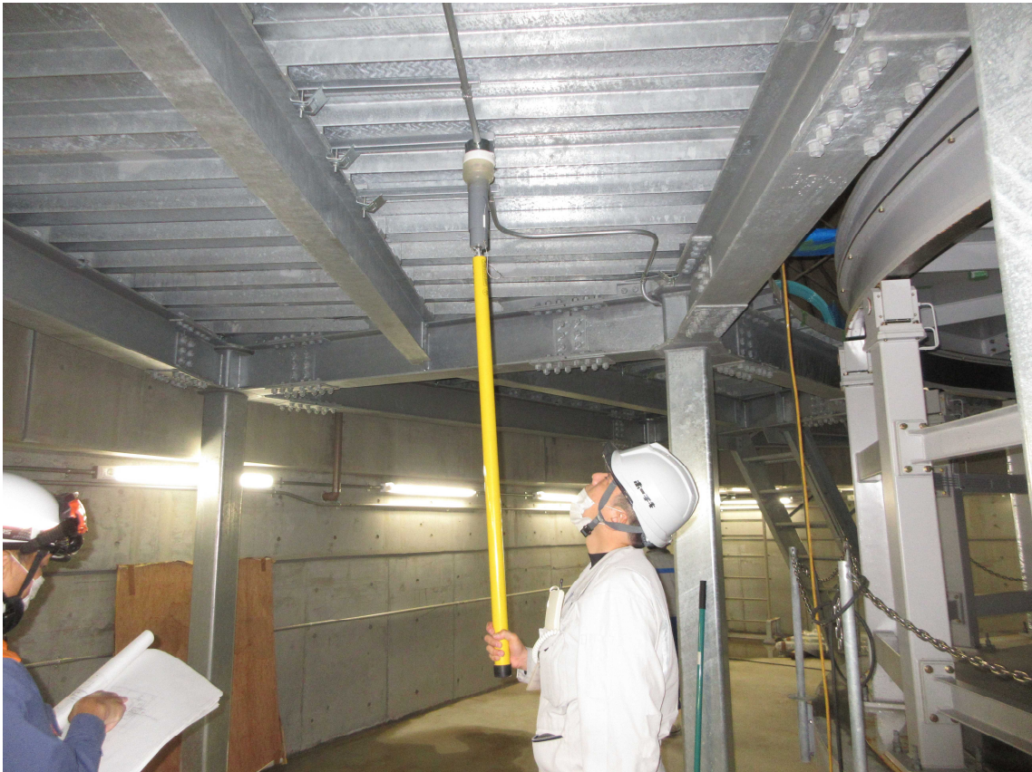
消防用設備設置検査中
