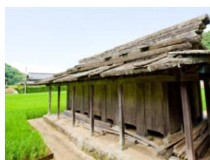
椎根の石屋根倉庫
