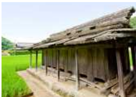
厳原町椎根の石屋根倉庫
