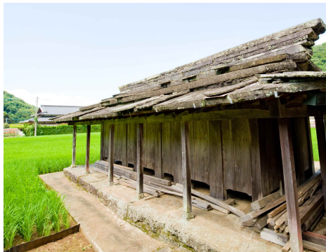
厳原町椎根の石屋根倉庫
