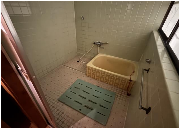
浴室＋洗濯機置き場
