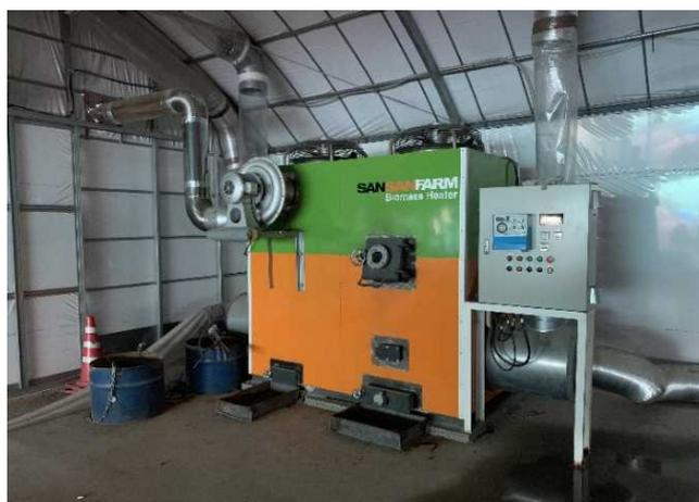
写真 12 原木しいたけの廃ホダ(木質バイオマス)を燃料とするボイラー。新たなしいたけ生産の熱エネルギーとして利用されている
