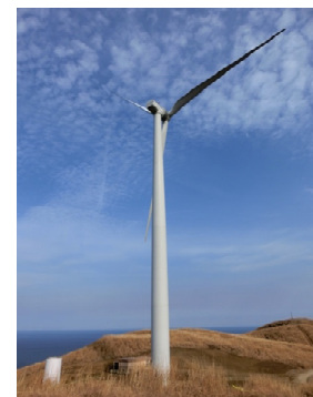
写真:対馬風力発電所 2016年報告者撮影
