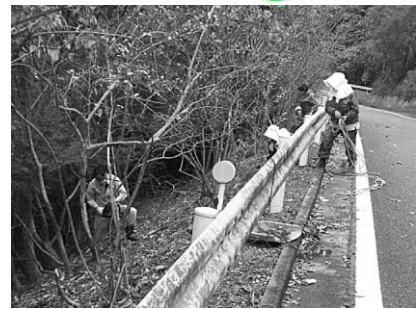
傾斜地での人力作業は危険で大変 安全第一で作業しました
