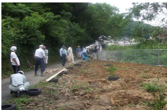
地域マネージャー制度（原材料を市から受給して地区で実施）を利用して通学路の危険箇所にフェンスを設置
