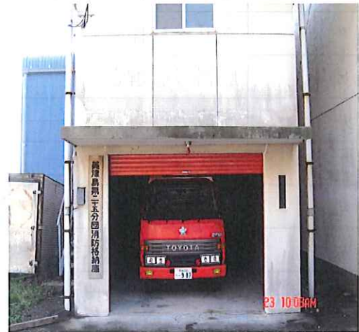
《消防格納庫・消防自動車》
