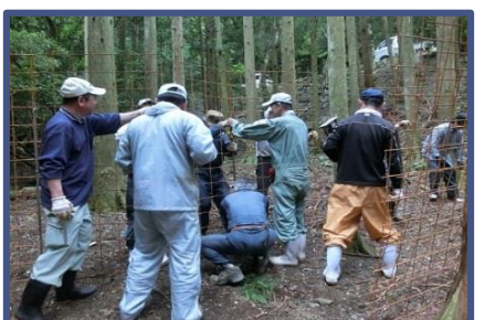
イノシシ・シカ防護柵設置作業
