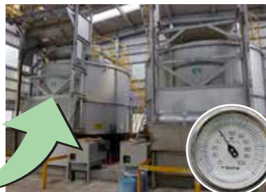
堆肥化施設 (美津島町根緒)
