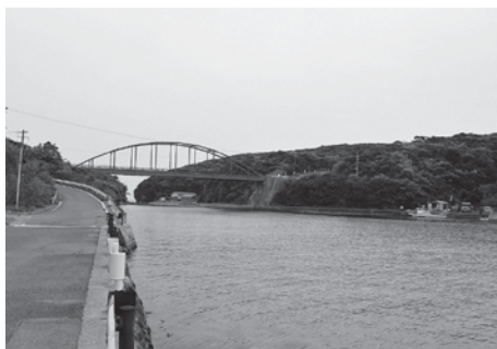
美津島町鴨居瀬・赤島大橋
