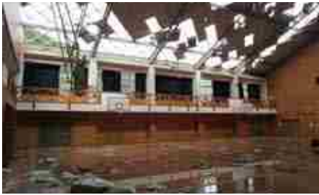
屋根が損壊した久田中体育館
